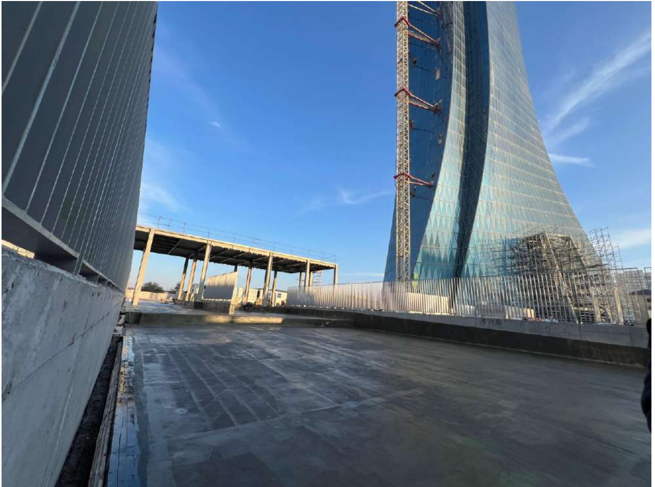
Mərkəzi Bankın Yeni İnzibati Binasında 1:2000 elastikliyinə sahib CCS PU-Bitum 2k bitum-poliuretan əsaslı hidroizolyasiya sistemi
