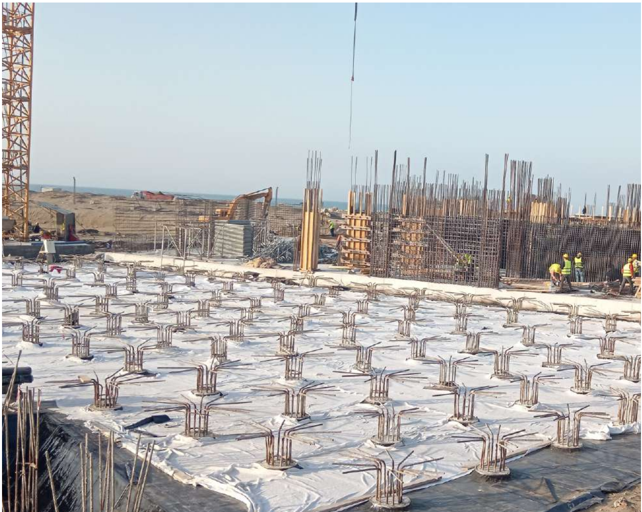
Sea Breeze Skyline Hotel & Residences bünövrəsində 900-dən çox svay başlıqların CCS ADD D5 qatqılı betonla təmiri və neqativ yöndən gələn sulara qarşı hidroizolyasiyası
