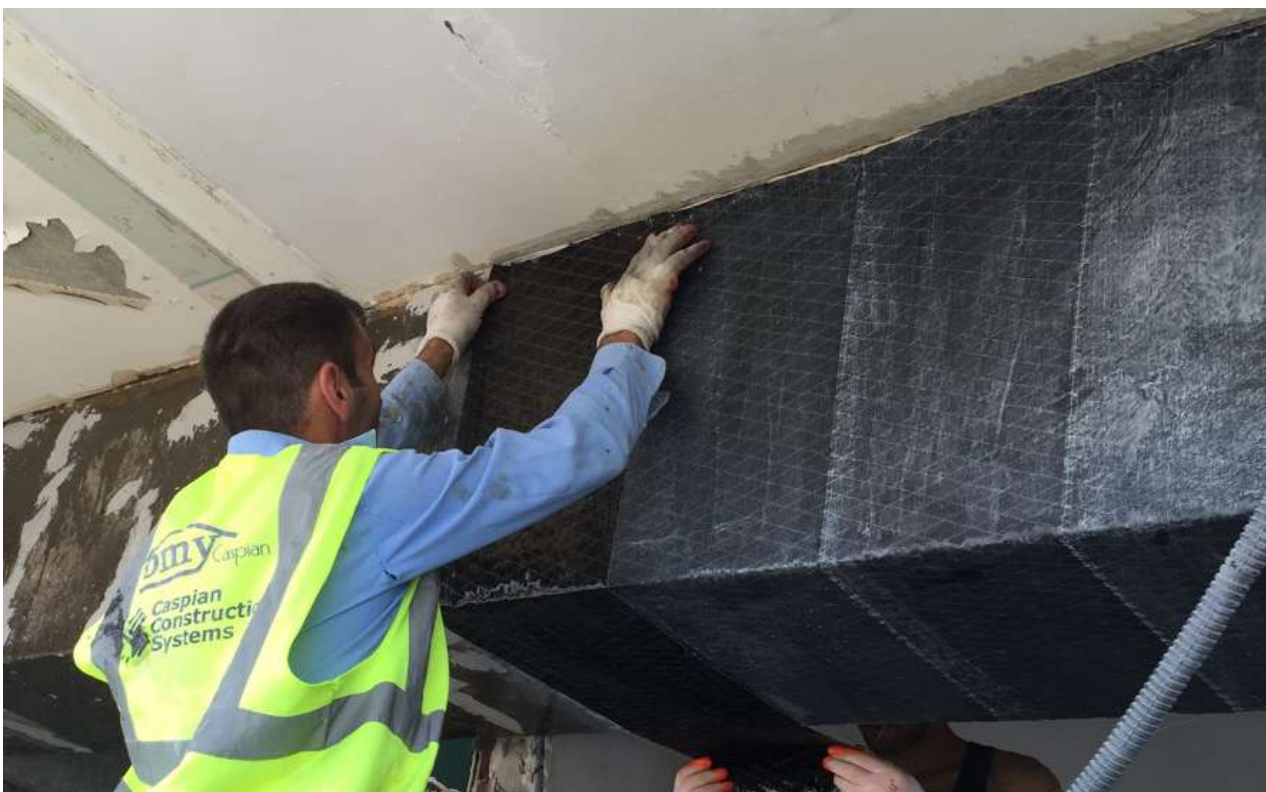
Bakı şəhəri Azadlıq prospektində yerləşən çoxmərtəbəli binanın CCS® CarbonFiber seriyalı konstruksiya gücləndirmə sistemləri ilə daşıyıcı elementlərinin bərpası
